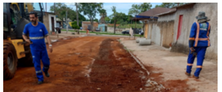
Cerca de 100 metros de galeria pluvial e duas bocas de lobo impedem alagamento
